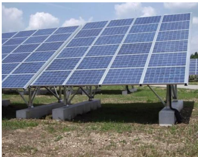
Εικόνα 3-10. Στήριξη με προκατασκευασμένα αντίβαρα
