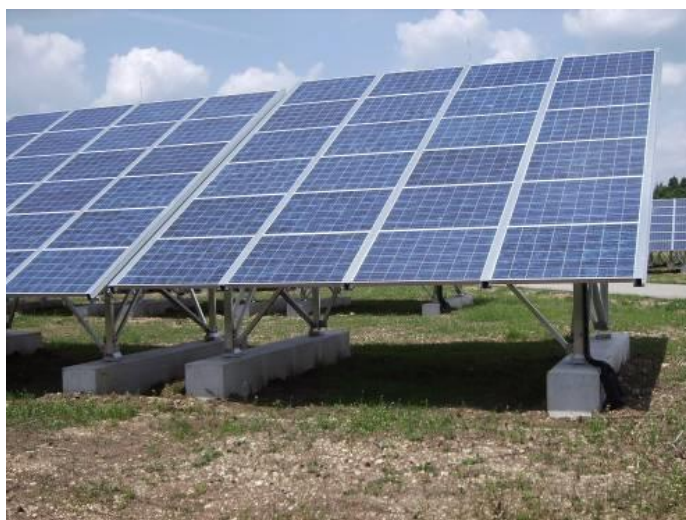
Εικόνα 2-7. Στήριξη με προκατασκευασμένα αντίβαρα
