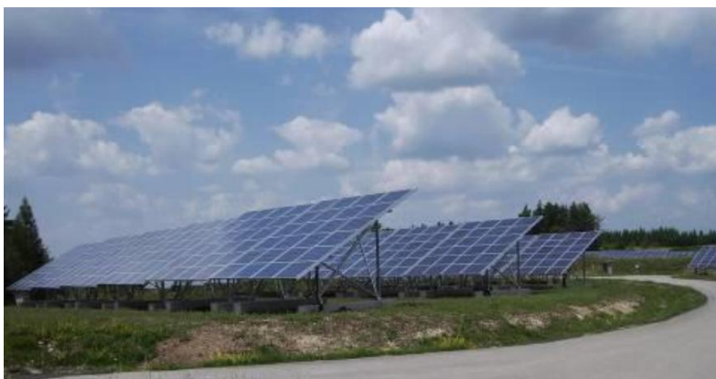
Εικόνα 3-7. Απεικόνιση ενδεικτικής έδρασης Φ/Β πλαισίων
