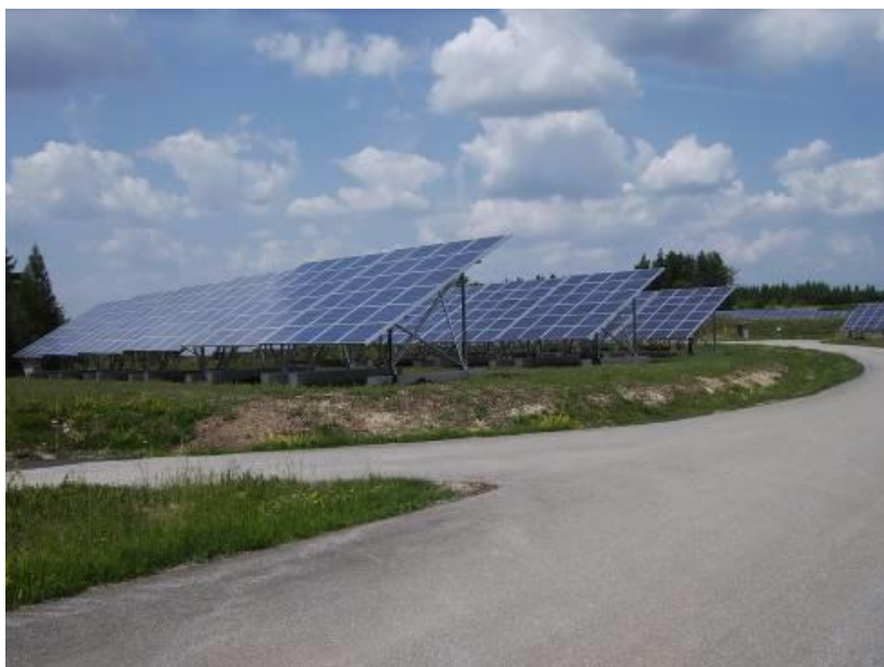
Εικόνα 2-4. Απεικόνιση ενδεικτικής έδρασης Φ/Β πλαισίων
