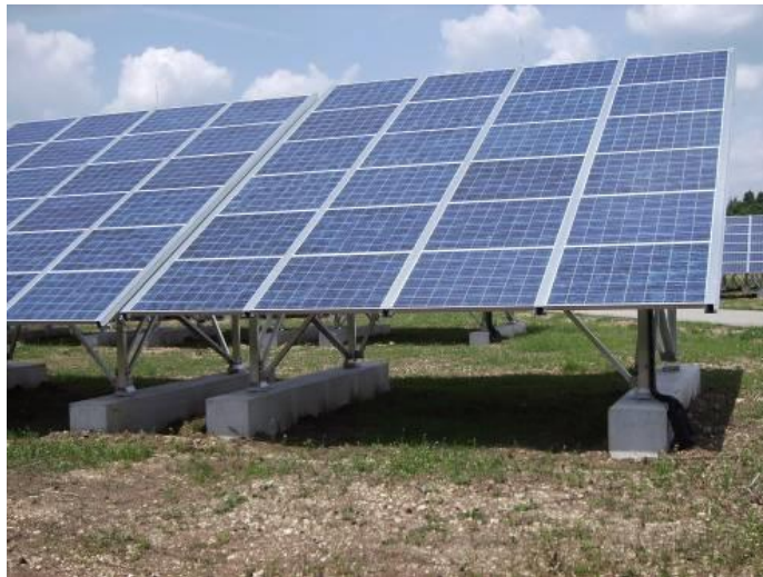
Εικόνα 2-7. Στήριξη με προκατασκευασμένα αντίβαρα
