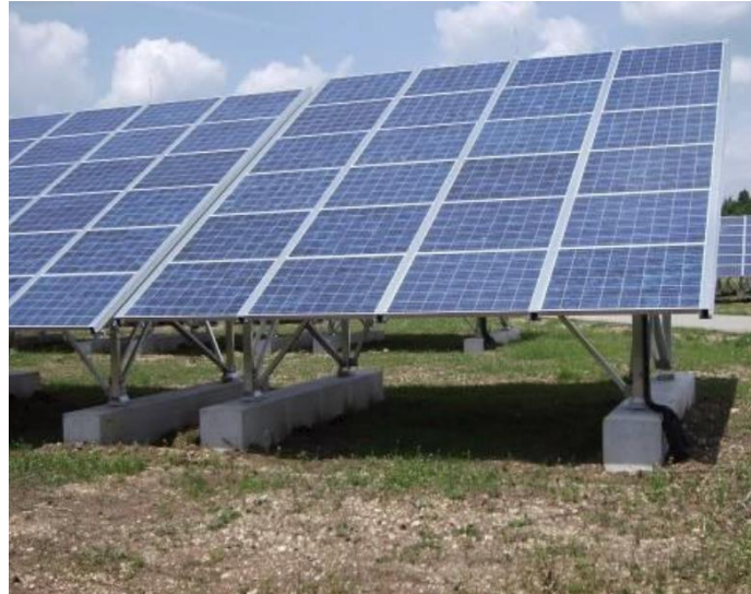
Εικόνα 3-10. Στήριξη με προκατασκευασμένα αντίβαρα
