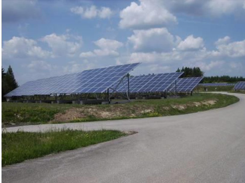
Εικόνα 2-4. Απεικόνιση ενδεικτικής έδρασης Φ/Β πλαισίων
