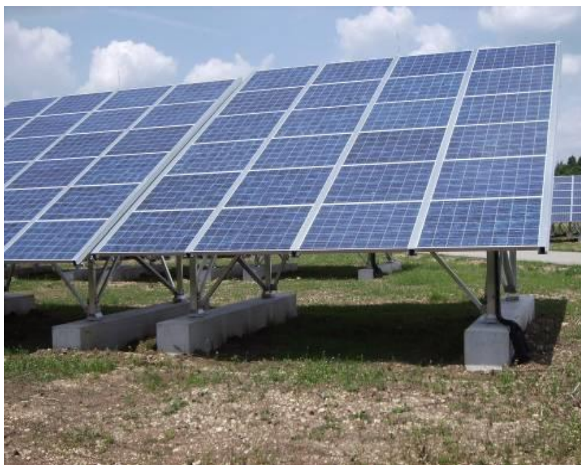
Εικόνα 6.8.: Στήριξη με προκατασκευασμένα αντίβαρα
