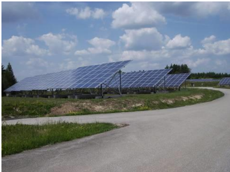
Εικόνα 3.3.: Απεικόνιση ενδεικτικής έδρασης Φ/Β πλαισίων
