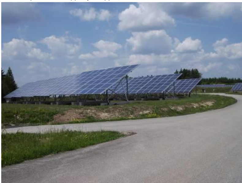
Εικόνα 3.3.: Απεικόνιση ενδεικτικής έδρασης Φ/Β πλαίσίων
