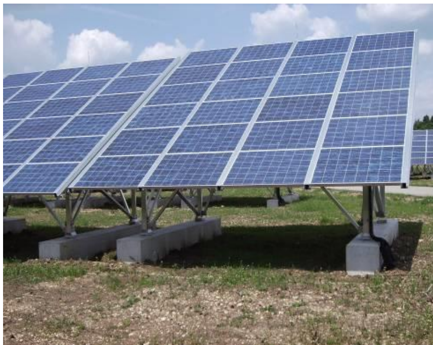
Εικόνα 6.8.: Στήριξη με προκατασκευασμένα αντίβαρα
